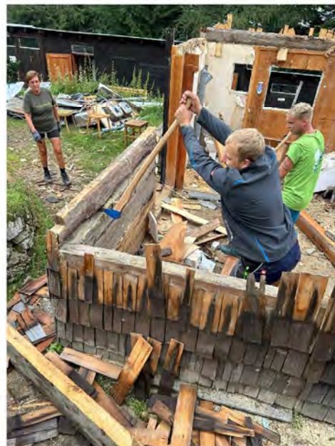
Beginn der Abrissarbeiten mit Unterstützung vieler ehrenamtlicher Helfer im August 2024
