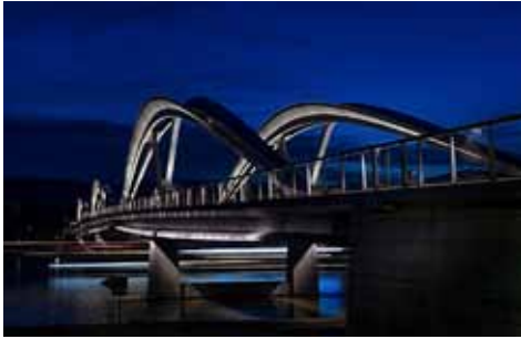
TRAUSINGER Walter (Allg.) „Eisenbahnbrücke“
